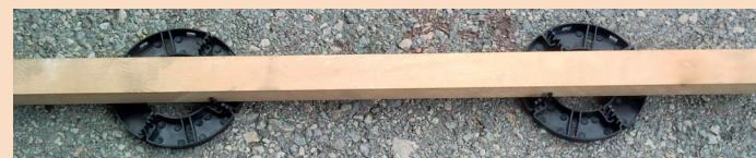
Terasový hranol o šířce do 96 mm vložte mezi kolíky terče. Pokud se hranol nevejde mezi vnitřní kolíky terče, postupně ulamujte vnitřní kolíky. Vnější kolíky musí na terci zůstat jako pojistka proti vysunutí terče mimo hranol během užívání. Případnou kombinací terčů a vyrovňávacích podložek dosáhnete bezpečné výšky až do 300 mm.
